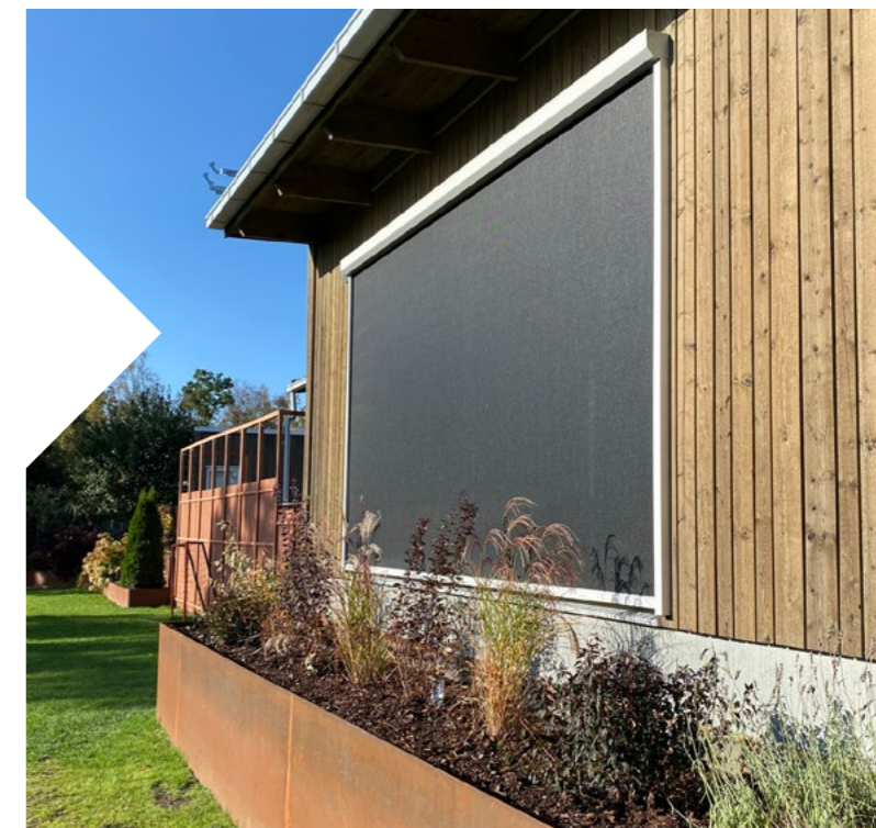
Solskydd som minskar värmeinstrålning med upp till 85% och därmed resulterar i reducerat kylbehov, kan också användas för att minska kallras.
